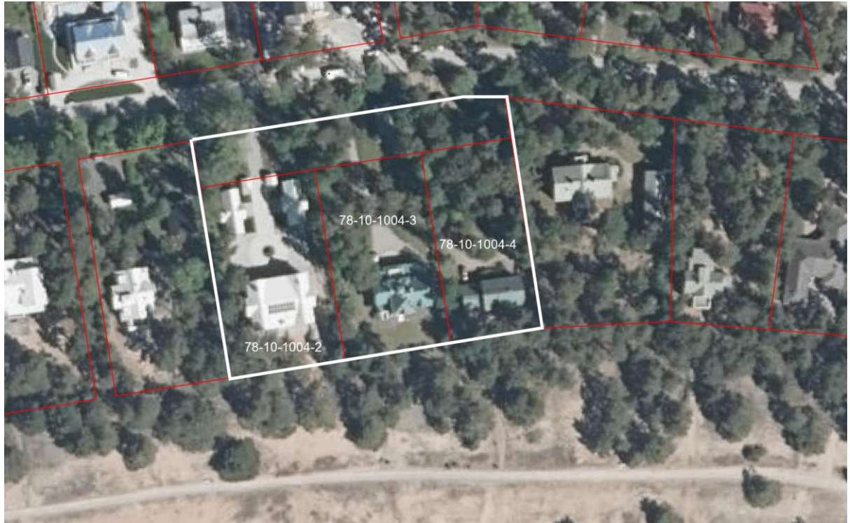
Ilmakuva kaavamuutosalueesta. Kiinteistörajat ovat punaisilla ja kaavamuutosalueen raja on valkoisella viivalla. Kiinteistönumerot ovat kunkin alueen kohdalla.
