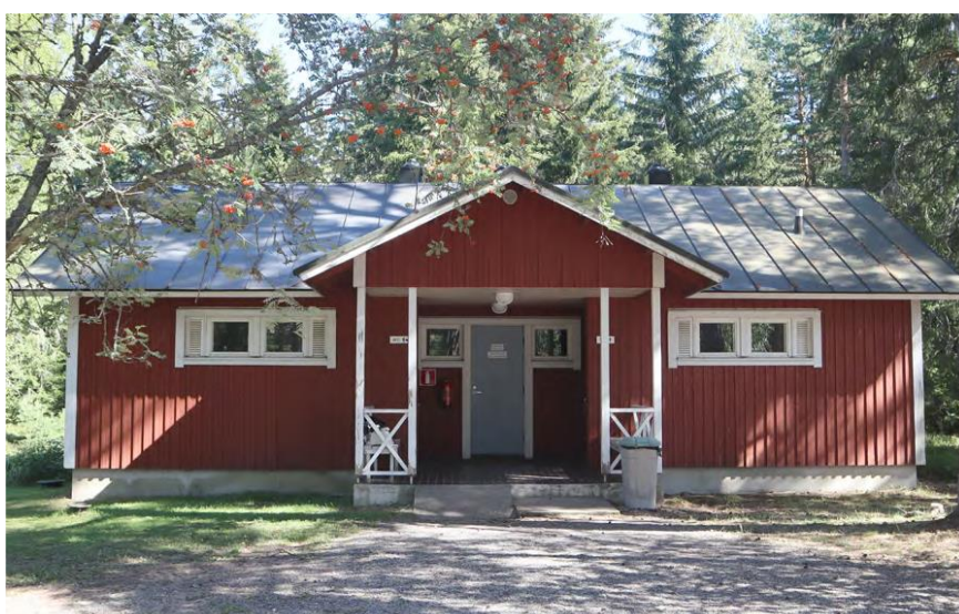
3. Socialbyggnad, wc och tvättrum (1989)
