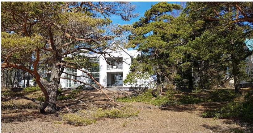
Mannerheimintie 10 on uudempaa rakennuskantaa edustava asuinrakennus alueella.
