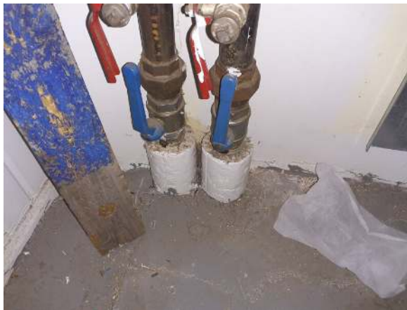
66. Lämpöjohtojen eristyksiä.
