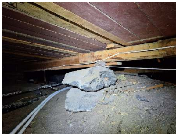
16. Alkuperäinen rakennusosa on tuettu kiviladonnoilla.
