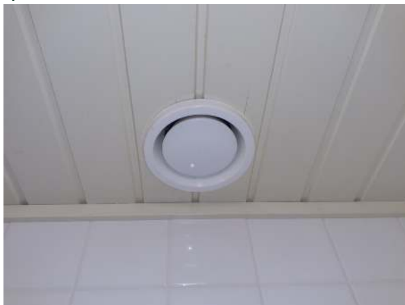
105. Poistoilmaventtiili (koneellinen).
