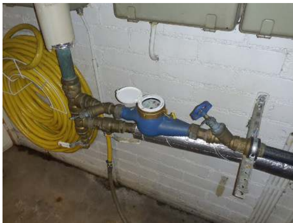
67. Kiinteistön päävesimittari.
