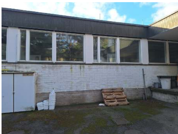
17. Keittiölaajennuksen sokkeli on teräsbetonia.
