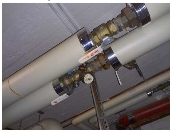
58. Linjasäätö- ja sulkuventtiilipari vuodelta 2005.
