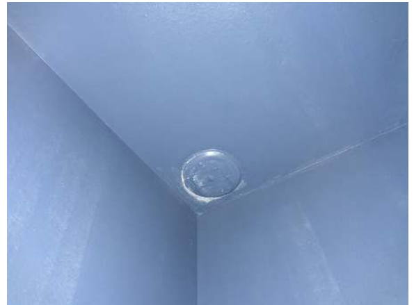
104. Poistoilmaventtiili (painovoimainen).
