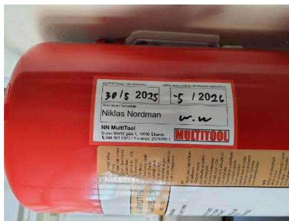
116. Käsisammutin tarkastettu.
