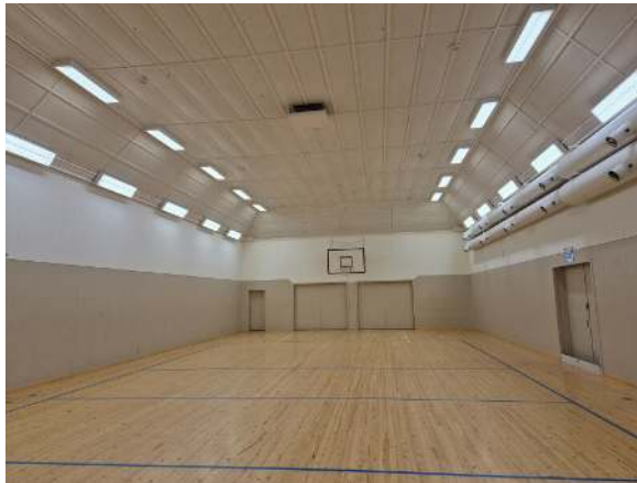
135. Liikuntasalissa vanhat valaisimet, mutta niihin on vaihdettu led-valonlähteet.
