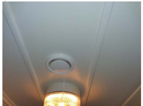
106. Poistoilmaventtiili (koneellinen).
