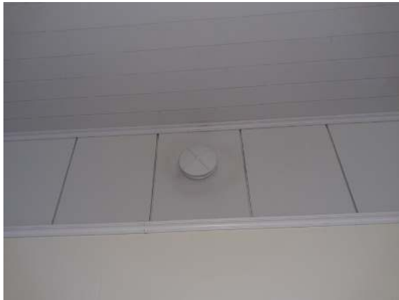
103. Poistoilmaventtiili (painovoimainen).
