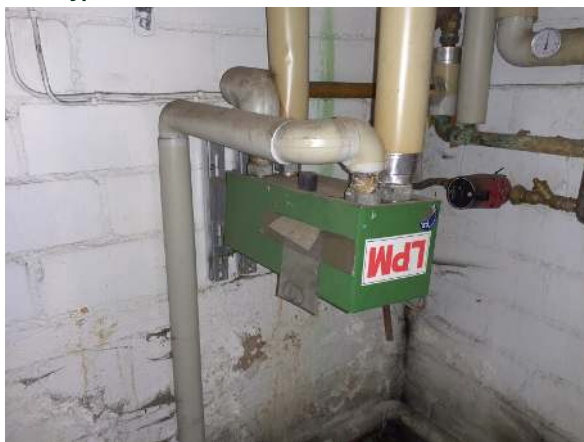
53. Lämmönsiirrin (käyttövesi).
