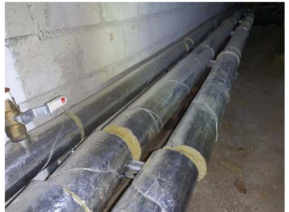
73. Uusittuja vesijohtoja (komposiittia).
