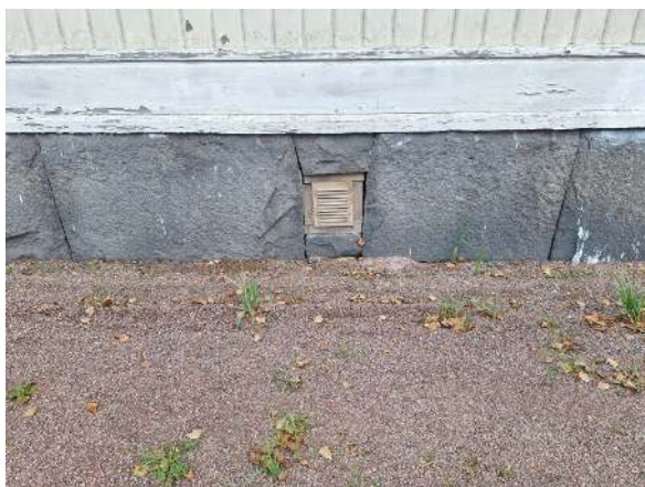
15. Alkuperäisen rakennusosan sokkeli on luonnonkiveä.
