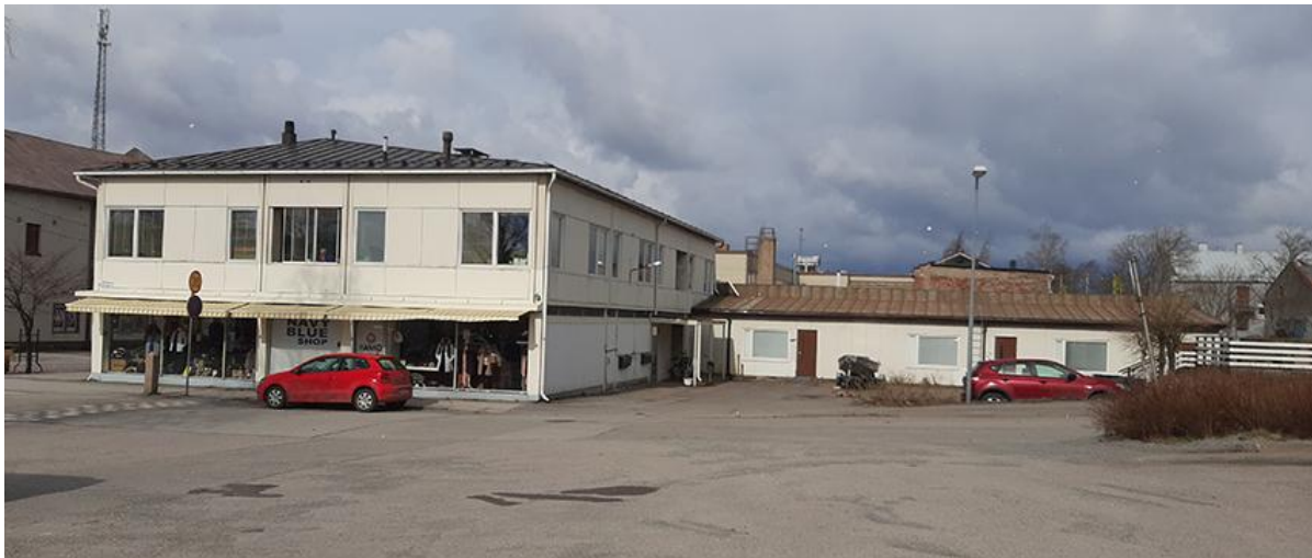
Korttelin 209 tontin rakennus kuvattuna Tornikadun suunnasta.
